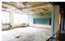
震災遺構 仙台市立荒浜小学校 宮城県仙台市 2017年4月公開開始
