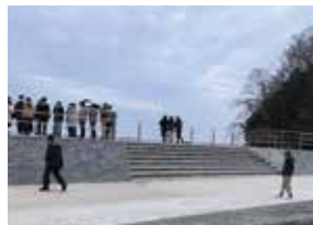
▲「雄勝石」が張られた防潮堤(波板地区)
