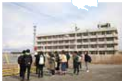
津波で被災した荒浜小学校(震災遺構・仙台市)の見学
