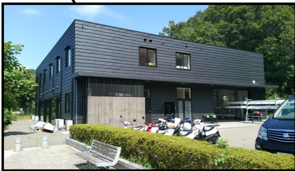
← 会場（釜房ボート艇庫）外観
