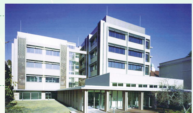
生命科学プロジェクト総合研究棟
