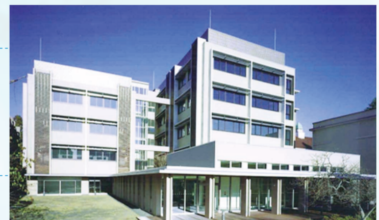
生命科学プロジェクト総合研究棟
